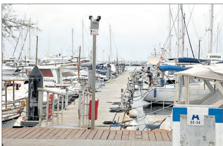
Les càmeres instal·lades al port esportiu. GERARD BLANCHÉ
