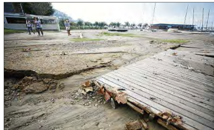
Estat en què va quedar una passarel·la de la platja.
