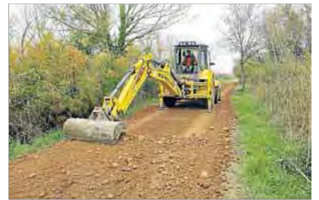
La màquina ha escampat terra per anivellar el camí, que estava en molt mal estat ■ AJUNTAMENT DE CASTELLÓ
