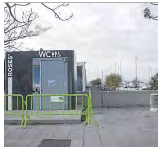
El mòdul instal·lat al port de Roses que està a punt d'entrar en funcionament ■ AJUNTAMENT DE ROSES
