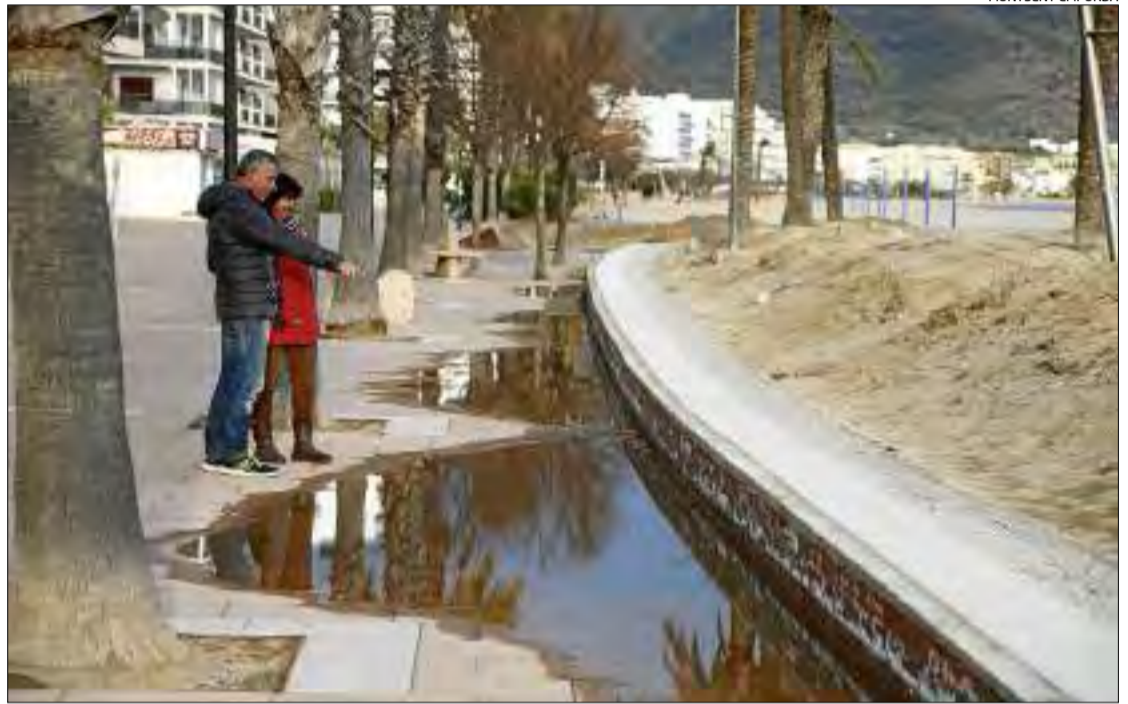
Les obres que s'estan portant a terme al passeig de Roses.
