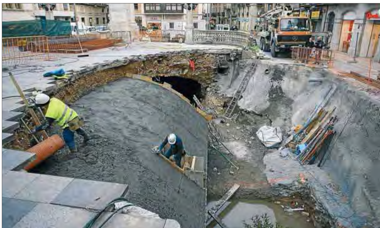
Ahir es va formigonar la volta que s'ha hagut de reconstruir per tancar l'esvoranc de la Rambla ■ LLUÍS SERRAT
