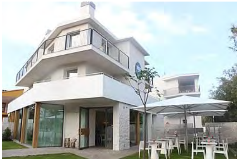
El 1935 Hotel & Apartaments ubicat a la urbanització Salatà de Santa Margarida, Roses
