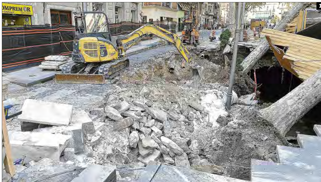
► LES PRIMERES ACTUACIONS 1 L'excavadora seguia ahir enretirant runa de la demolició controlada. 2 Una màquina fent els sondejos. 3 El bombeig d'aigua de dilluns al pàrquing Passeig Nou.
