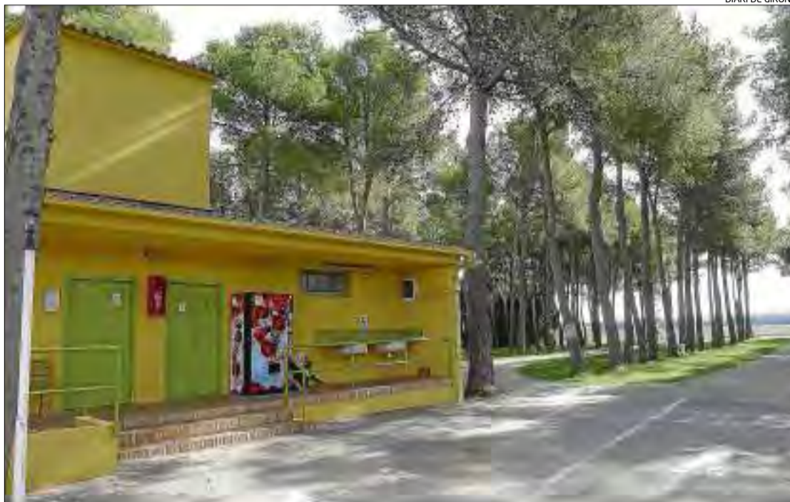
Les instal·lacions actuals del càmping Pous de Figueres, de les quals només funciona una part.
