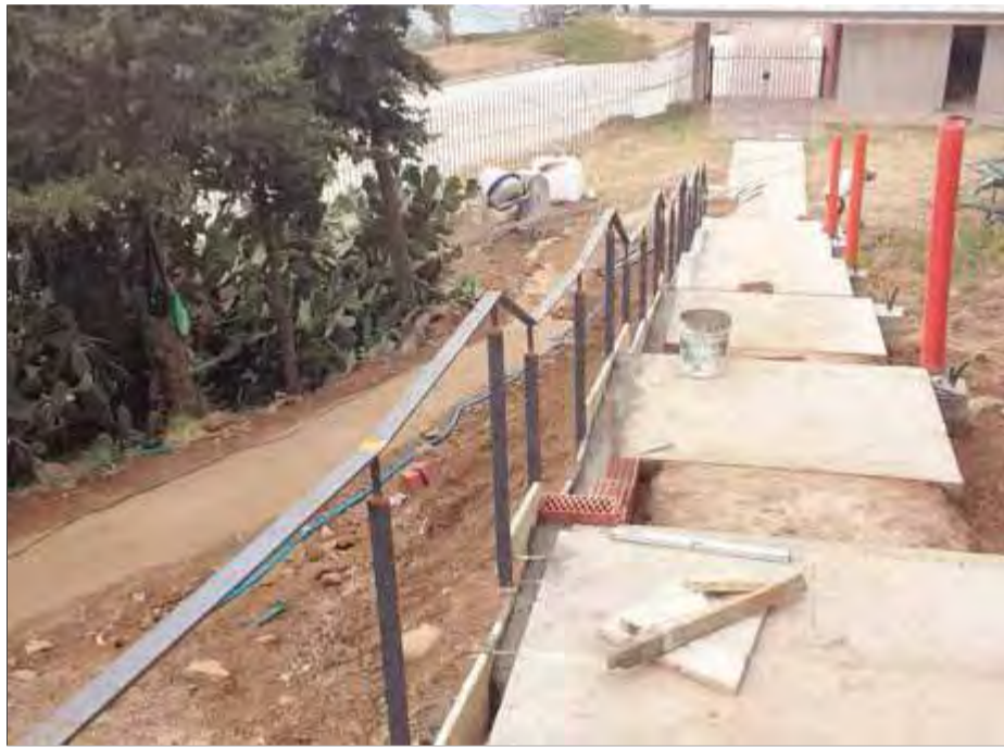
Les obres a les escales d'accés al castell ja han començat ■ EL PUNT AVUI
