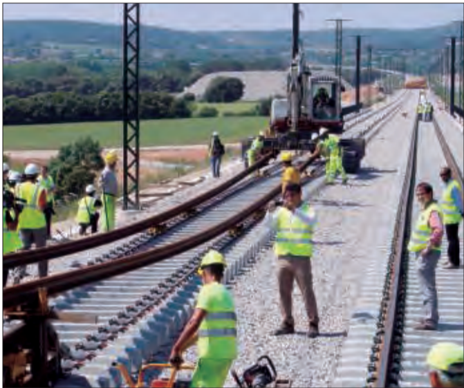
Obres de construcció de la línia de l'AVE. ARXIU
