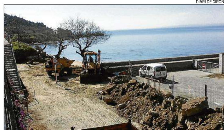
Les obres que s'estan portant a terme a la platja dels Palangrers.
