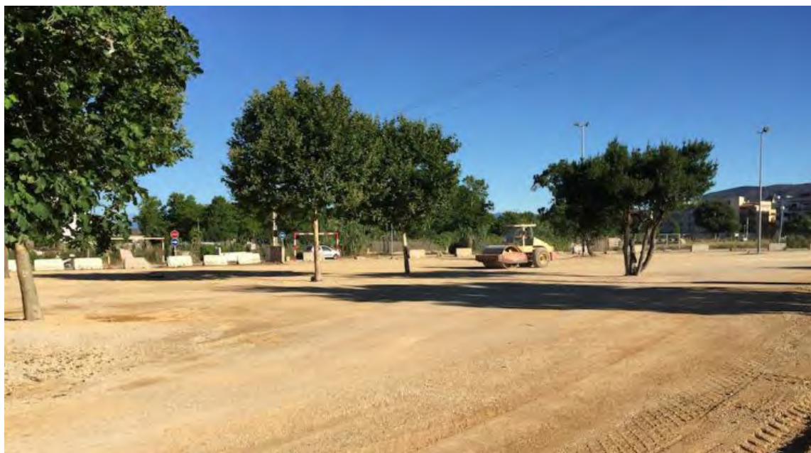
Els operaris acabant de treballar en l'adequació dels terrenys
