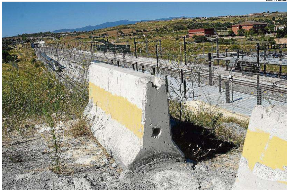
La infraestructura talla la continuïtat del camí que comunica amb la Garriga d'Empordà.
