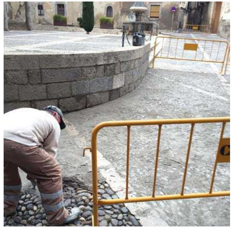
TRÀNSIT TALLAT. Ho estarà fins que s'acabin els treballs
