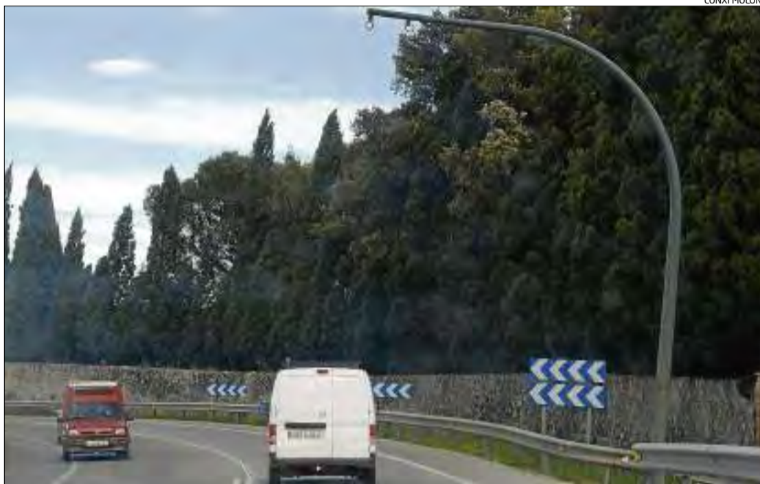
L'estructura del semàfor que es va trencar fa més de mig any al revolt de Can Massanet.
