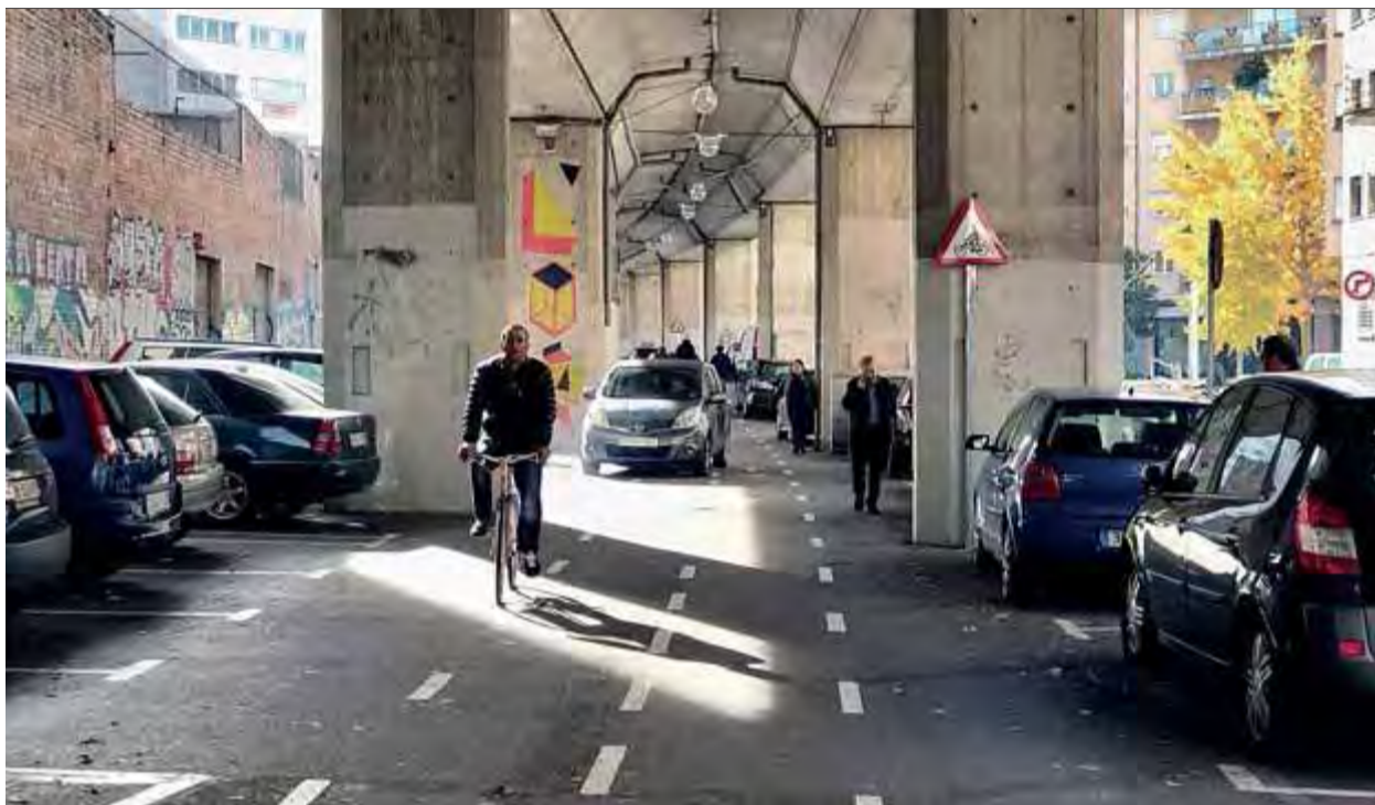
El carril bici que es va construir sota el viaducte, entre el carrer Santa Eugènia i la Ronda Ferran Puig ■ JORDI NADAL
