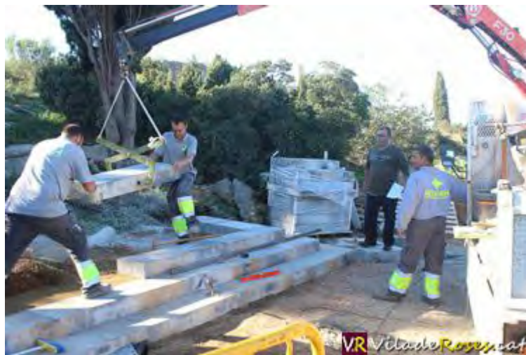
Els operaris de Rosersa col·locant un dels esglaons de la nova escala que tindrà el mirador del Puig Rom de Roses
