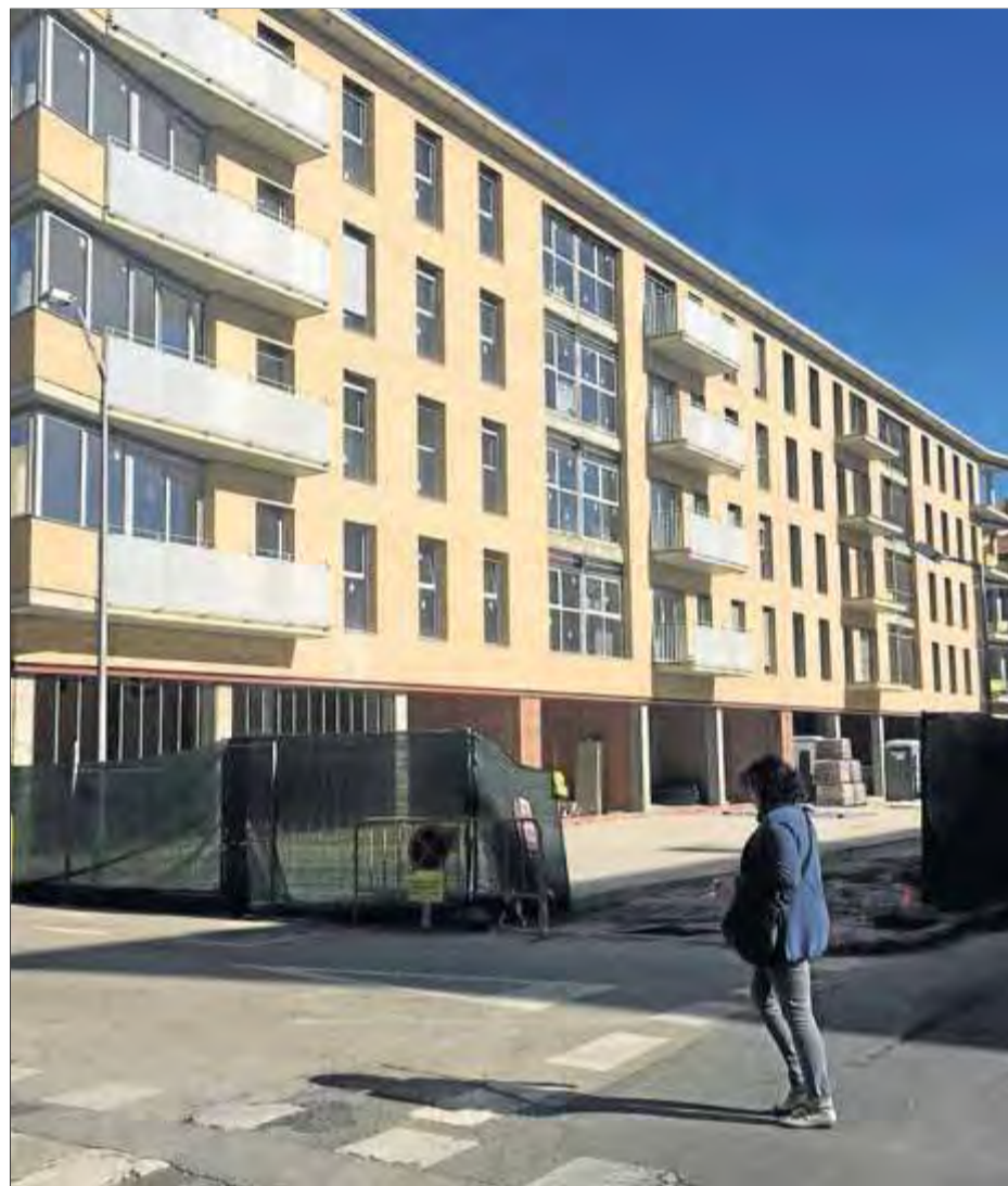
El bloc de pisos la construcció del qual s'ha reprès ■ J.N.
