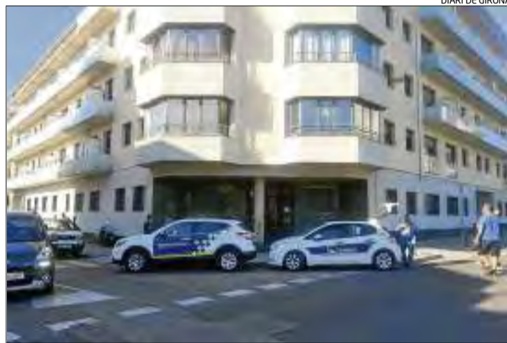
L'operatiu policial ahir a l'edifici del carrer Torres i Bages.
