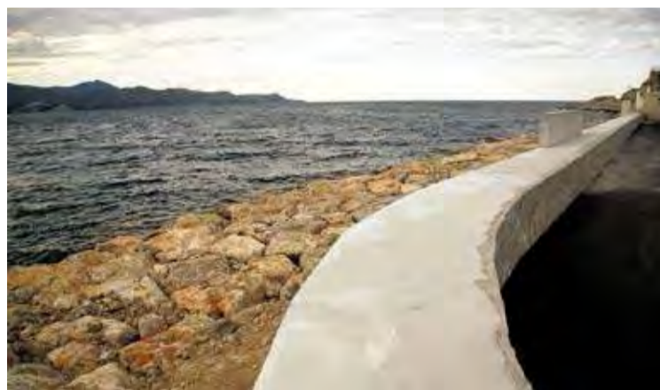
NOU TRAM DE MUR. S'ha complementat amb blocs d'escullera i nou paviment
