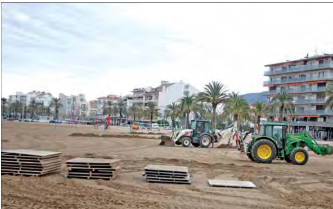
Les màquines de Rosersa, apilant les estructures de fusta a la platja de Roses. MONTSENY EMPORDÀ
