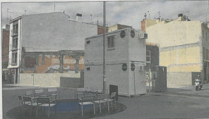
El solar després d'enderrocar-se l'edifici.
