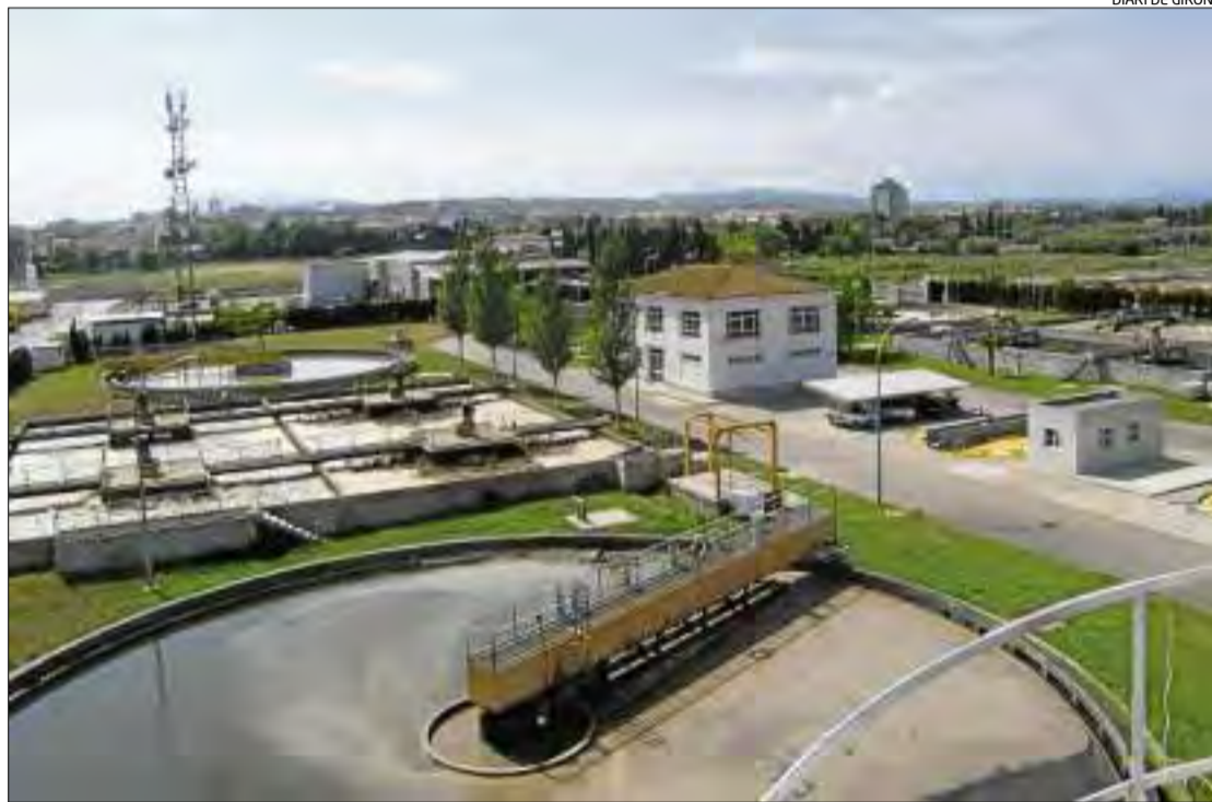
La depuradora es va construir l'any 1982 i es va ampliar el 1993.
