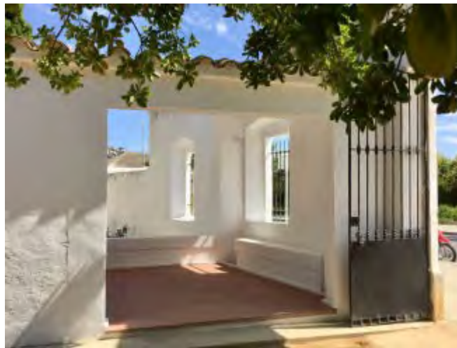
Treballs de millora al cementiri de Roses EMPORDA.INFO
