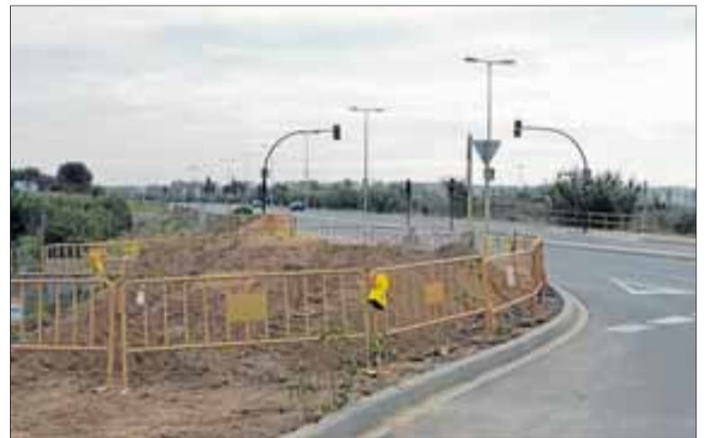
La actuación, ya finalizada, se llevó a cabo en el tramo comprendido entre el Camí dels Morts y el camping. FOTO: CEDIDA
