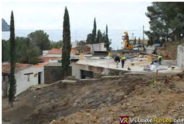
Operaris treballant aquest matí en el 20% del projecte de elBulliFoundation
