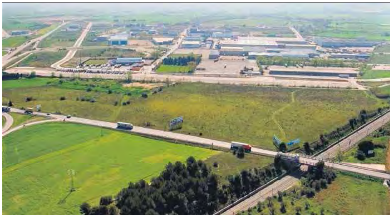
Vista aèria de la terminal de Vilamalla ■ EL PUNT AVUI
