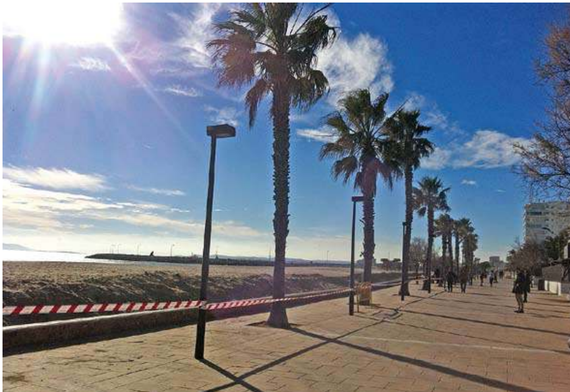
A SANTA MARGARIDA. Ja han començat els treballs que també inclouen actuacions entre la sorra i el paviment
