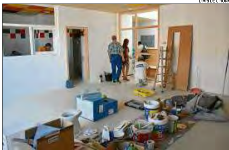
L'espai que s'adequarà a l'interior de l'edifici actual.
