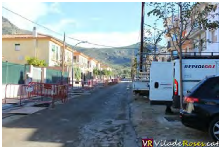
Canalització del gas a la urbanització Mas Oliva de Roses l'any 2014
