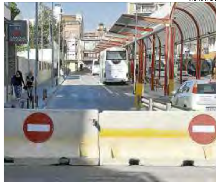
El vial amb els blocs de formigó que impedeixen el pas rodat.
