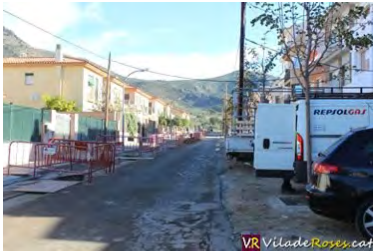
Canalització del gas ciutat al carrer Viena de la urbanització Mas Oliva de Roses
