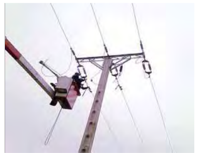
Treballadors d'Endesa en els treballs de reforçament de les línies elèctriques de mitjana tensió ■ EL PUNT AVUI
