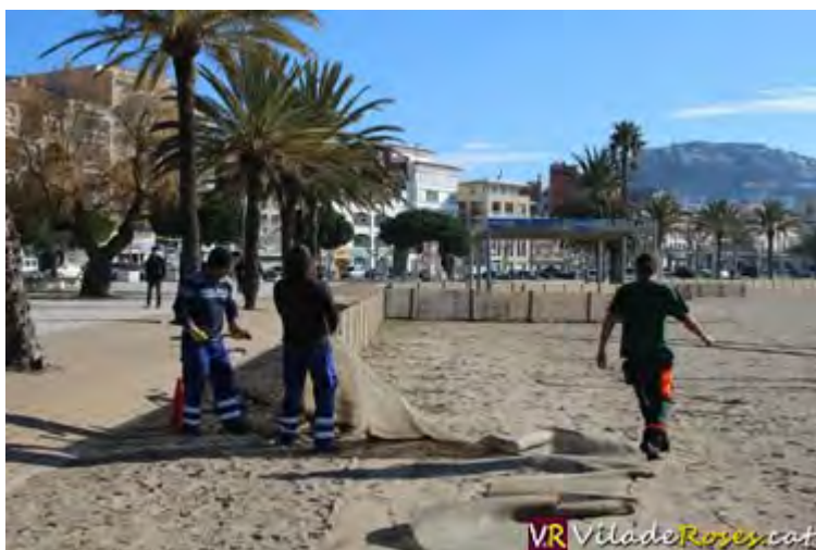
Treballadors de ROSERSA col·locant la lones protectores a la platja Nova de Roses
