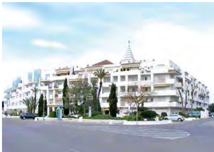
SENTENCIAT. Una ordre judicial establí que s'havia de demolar el quart pis HORA NOVA
