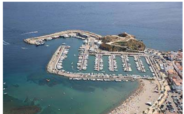
PORT DE LLANÇÀ. S'hi preveuen 53 noves lluminàries
