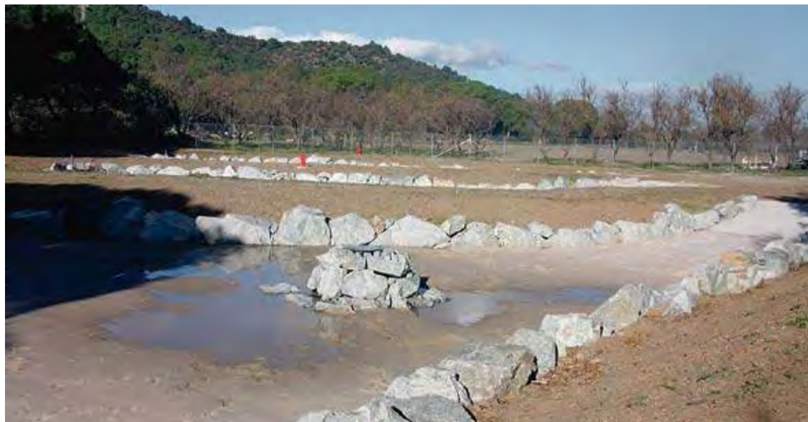
ZONA DE MALAJAMBOTA. És on es fa l'última fase del filtratge i on s'han habilitat les basses d'infiltració
