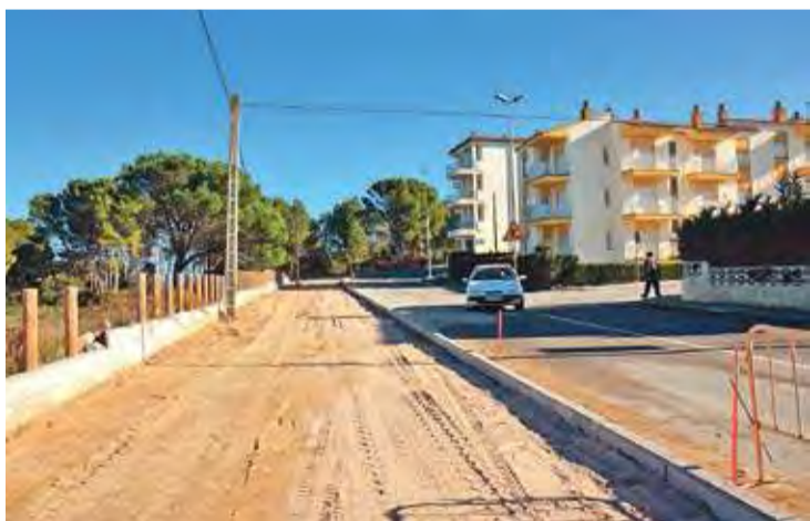
EN OBRES. Està previst que els treballs de Riells acabin abans de Nadal AJ. DE L'ESCALA
