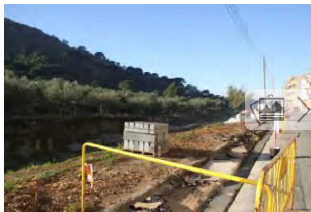
Les obres ja s'han iniciat. AJUNTAMENT DE ROSES
