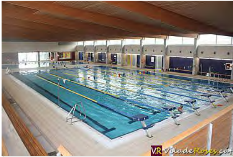
Aspecte de la instal·lació aquàtica de la Piscina Municipal de Roses
