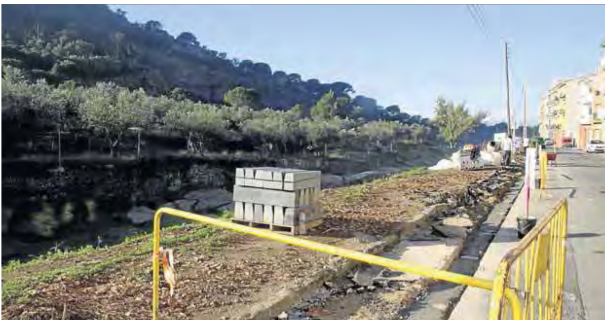
Aquesta setmana s'han iniciat les obres que transformaran aquest espai ■ AJUNTAMENT DE ROSES
