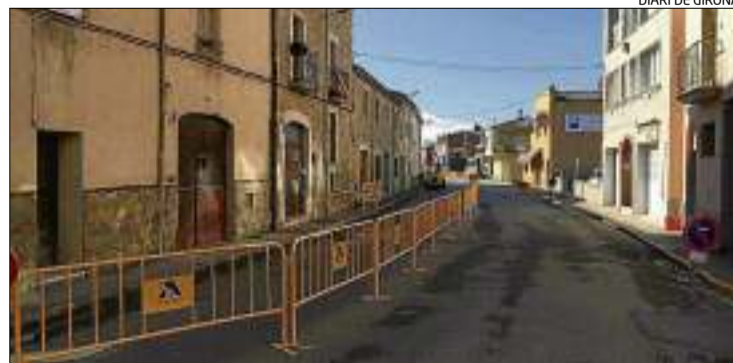
Una foto de les obres a un tram del carrer Perelló, ahir al matí.
