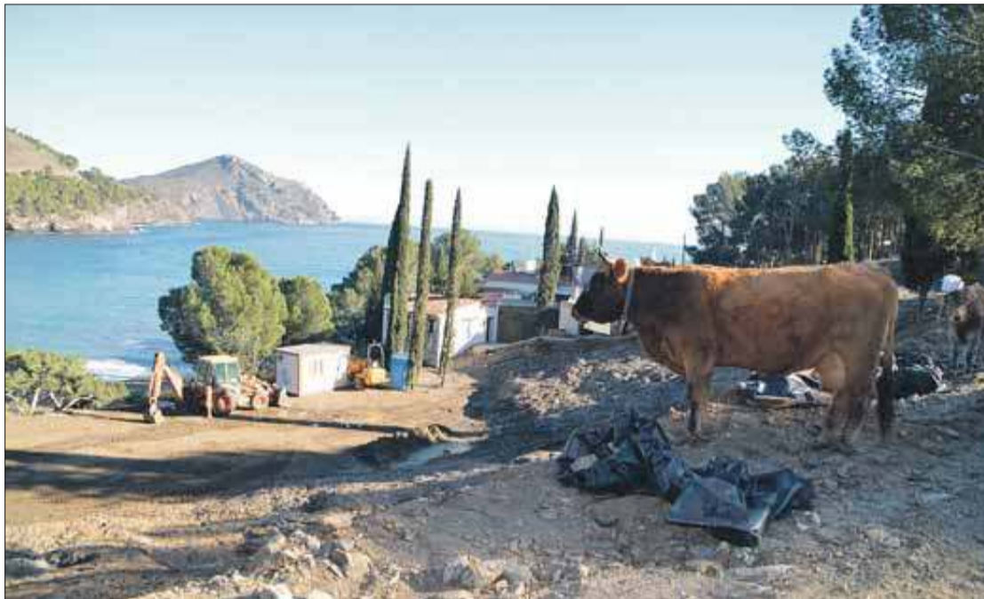
La primera fase de les obres d'elBulli1846 es van executant al ritme previst en un entorn bucòlic. SANTI COLL
