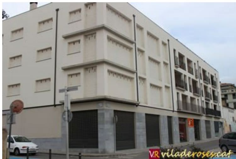
Bloc d'habitatges a Roses / Foto: arxiu
