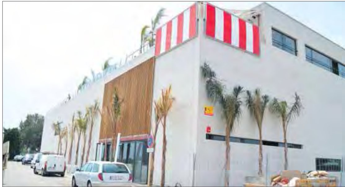
La nova ubicació de la discoteca Passarel·la, que reobre les portes aquest divendres. EMPORDÀ
