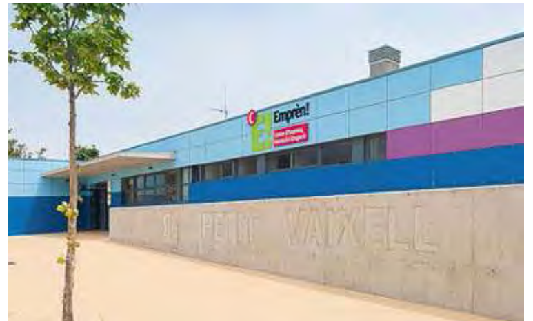
CENTRE EMPRÈN. És l'espai des d'on s'aniran executant totes les accions
