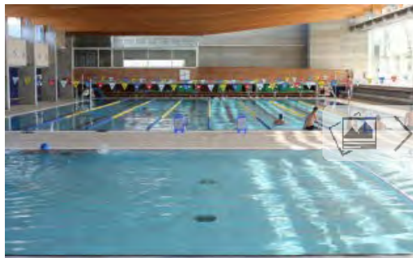
El vas principal de l'instal·lació. AR
