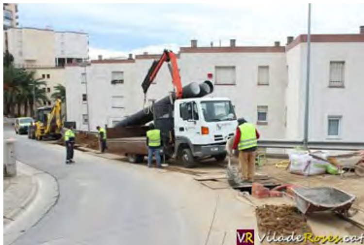
Operaris treballant en la instal·lació de canonades a l'entrada del Puig Rom
