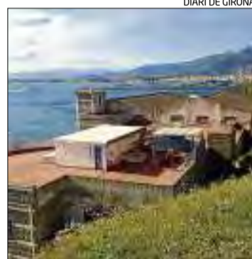
L'espai que ocupa la depuradora.
