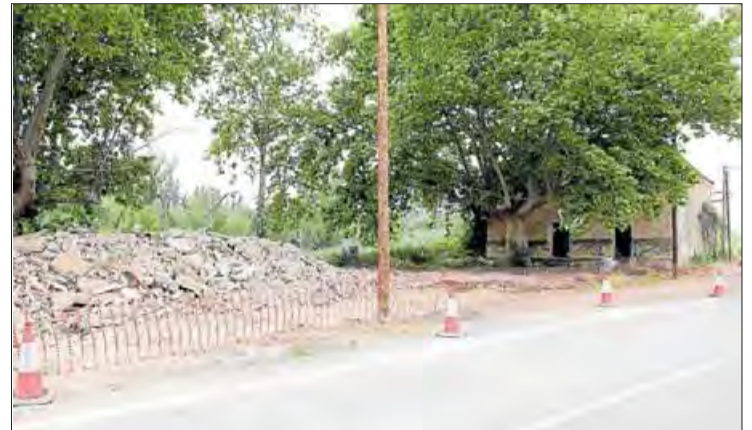
L'enderrocament de l'antiga estació de trens. GERARD BLANCHÉ
