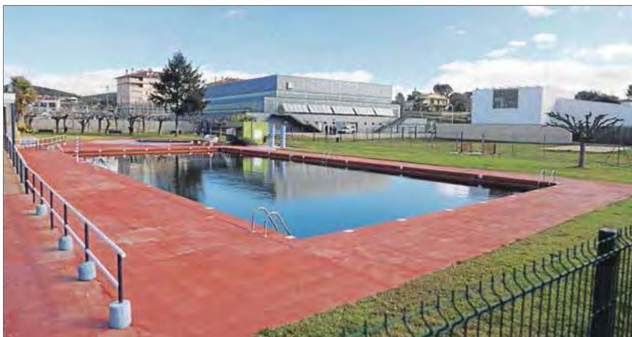
Les instal·lacions de la piscina municipal de Cassà de la Selva ■ MANEL LLADÓ
