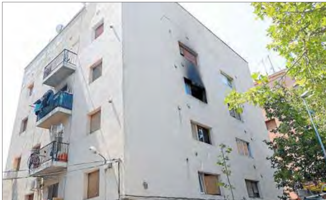
El bloc d'edificis situat al carrer Marià Llanvera de Figueres. CONXI MOLONS
