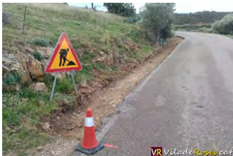
La nova cuneta de formigó comprén el tram des de la Torre del Sastre (a la imatge) fins la Riera de Montjoi
