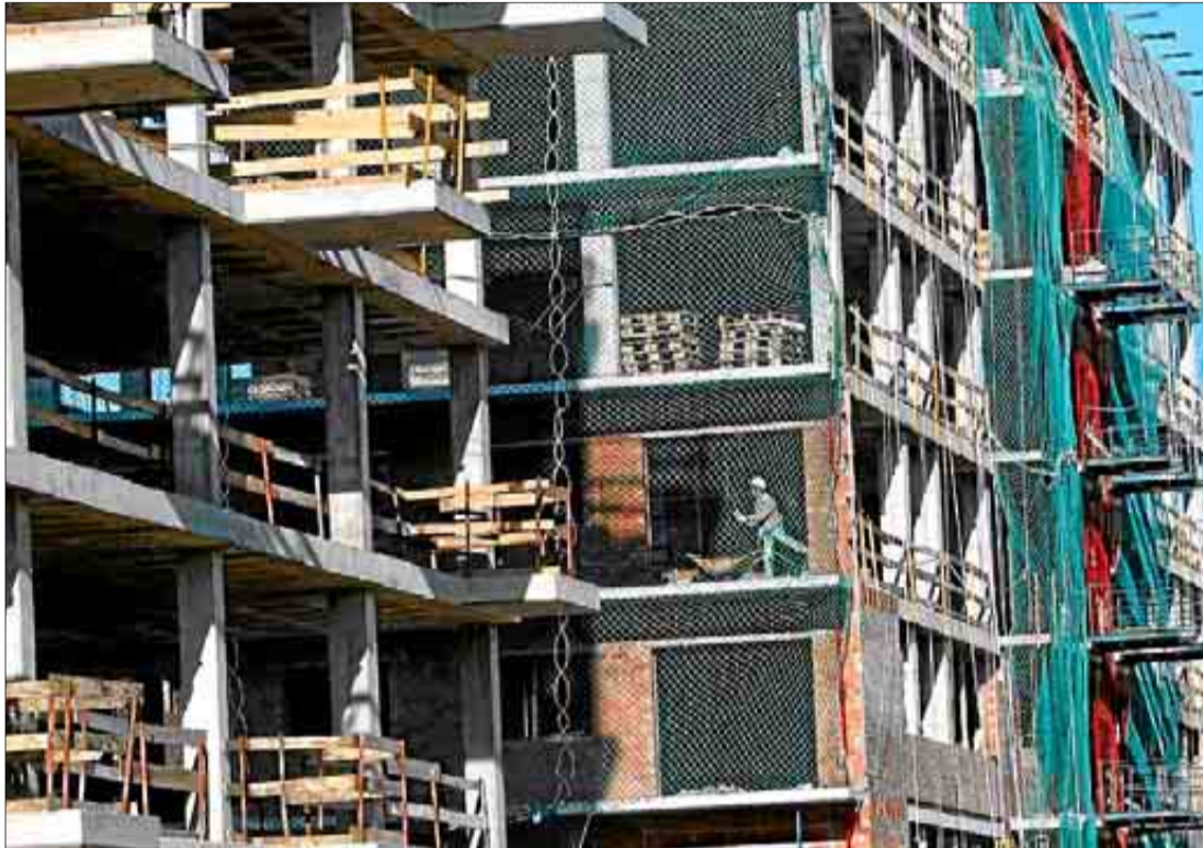
Edificio de viviendas en construcción. / QUIQUE GARCÍA
