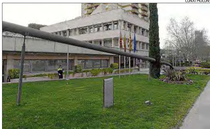
L'edifici municipal de l'avinguda Dalí afectat pel tall.
