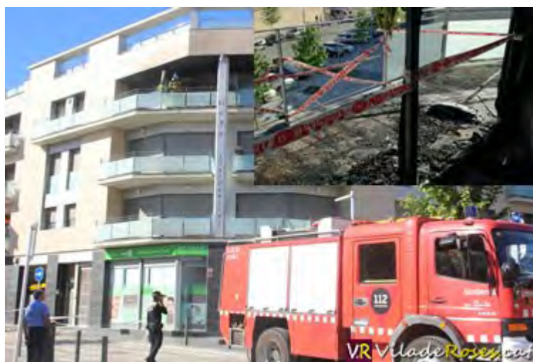
El foc s'ha originat al balcó del tercer pis de l'edifici Nou Goya Residencial. A la imatge petita detall del balcó cremat
