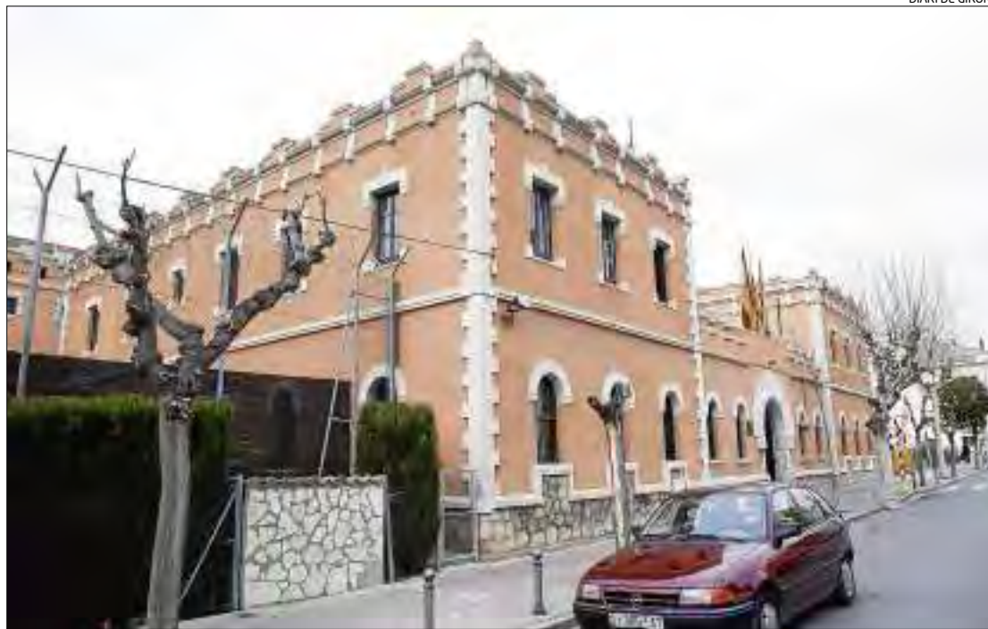
L'actual presó, que data de principis del 1900, està situada en ple centre i envoltada d'edificis.
